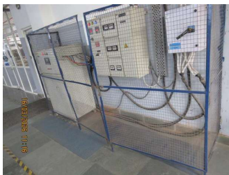
Fire alarm panel.JPG
